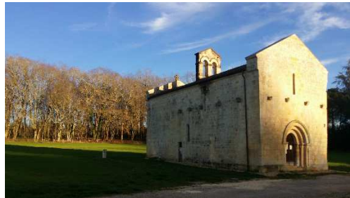
La chapelle de Tresséroux-Commune des Lèches
